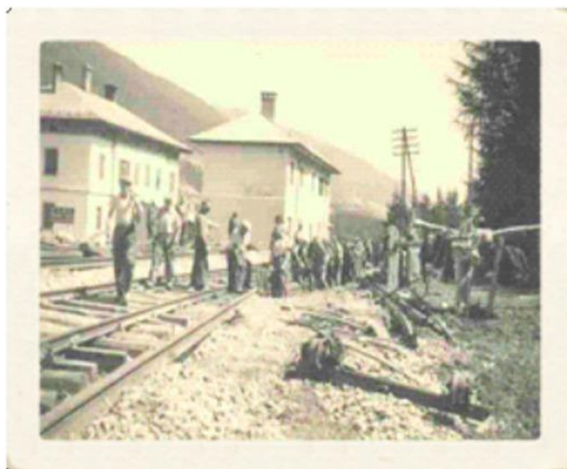
Sostituzione rotaie in linea
