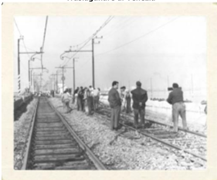
Livellamento binari sul ponte Traslagunare di Venezia
